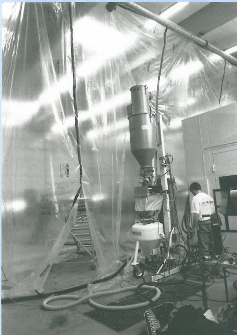
Uppkoppling av blästerutrustningen pågår
